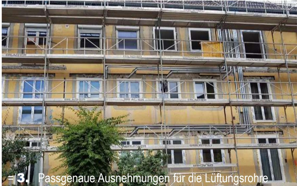
Passgenaue Ausnehmungen für die Lüftungsrohre
